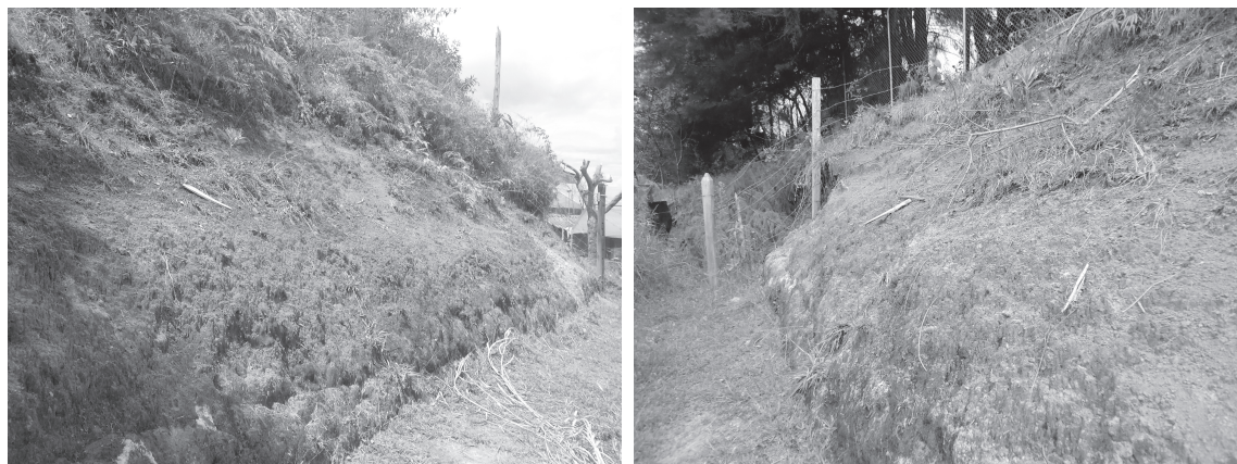
Figura 1. Estado inicial del talud.
