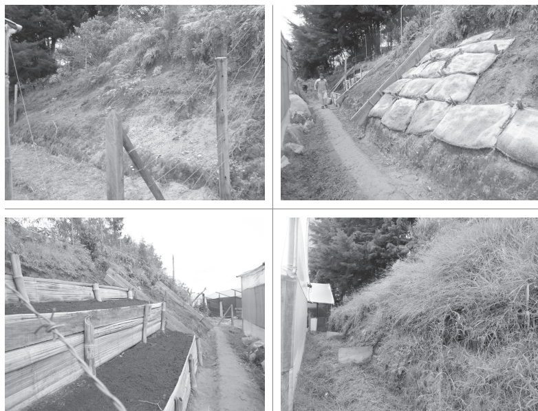
Figura 8. Estado inicial (izquierda), tratamientos de terraceo-costales y estado final (derecha) de las parcelas del talud después de 157 días.
